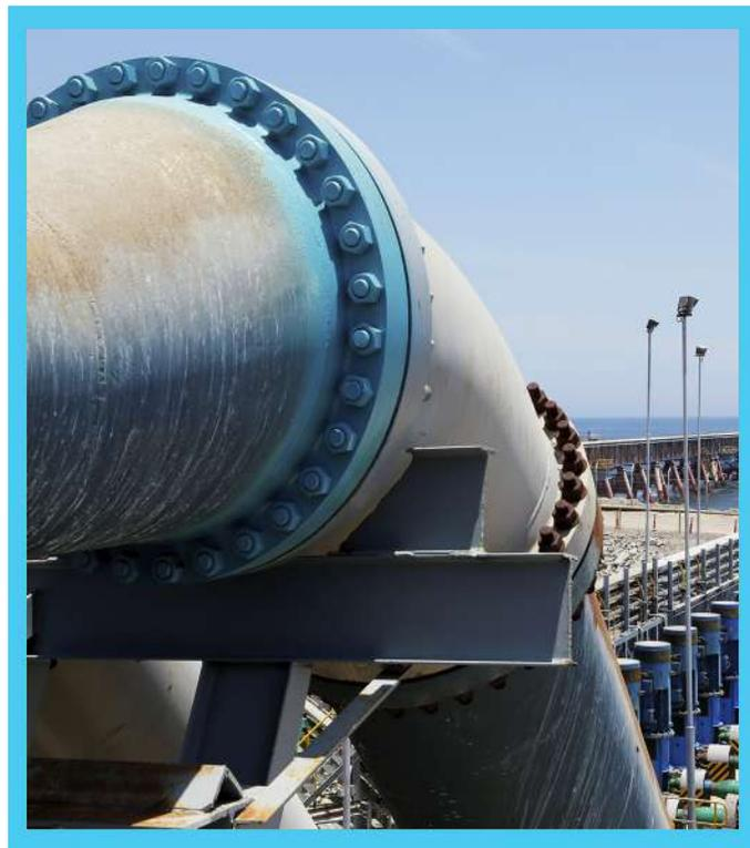
El proyecto de transporte de agua de Centinela incluye la adquisición y operación de una tubería de agua de 144 km de longitud que transporta 1.194 lps (110.678 m<sup>3</sup>/día), suministrando agua de mar a 60 km al norte del sitio minero en Michilla, donde se encuentra el puerto de Centinela. Además, contempla la construcción y operación de una nueva tubería de 144 km de longitud y 650 lps (56.333 m<sup>3</sup>/día) paralela a la tubería existente.
