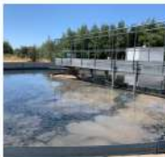
TRATAMIENTO DE AGUA
